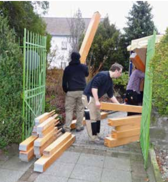
Abbau und Abtransport im Januar 2014.
